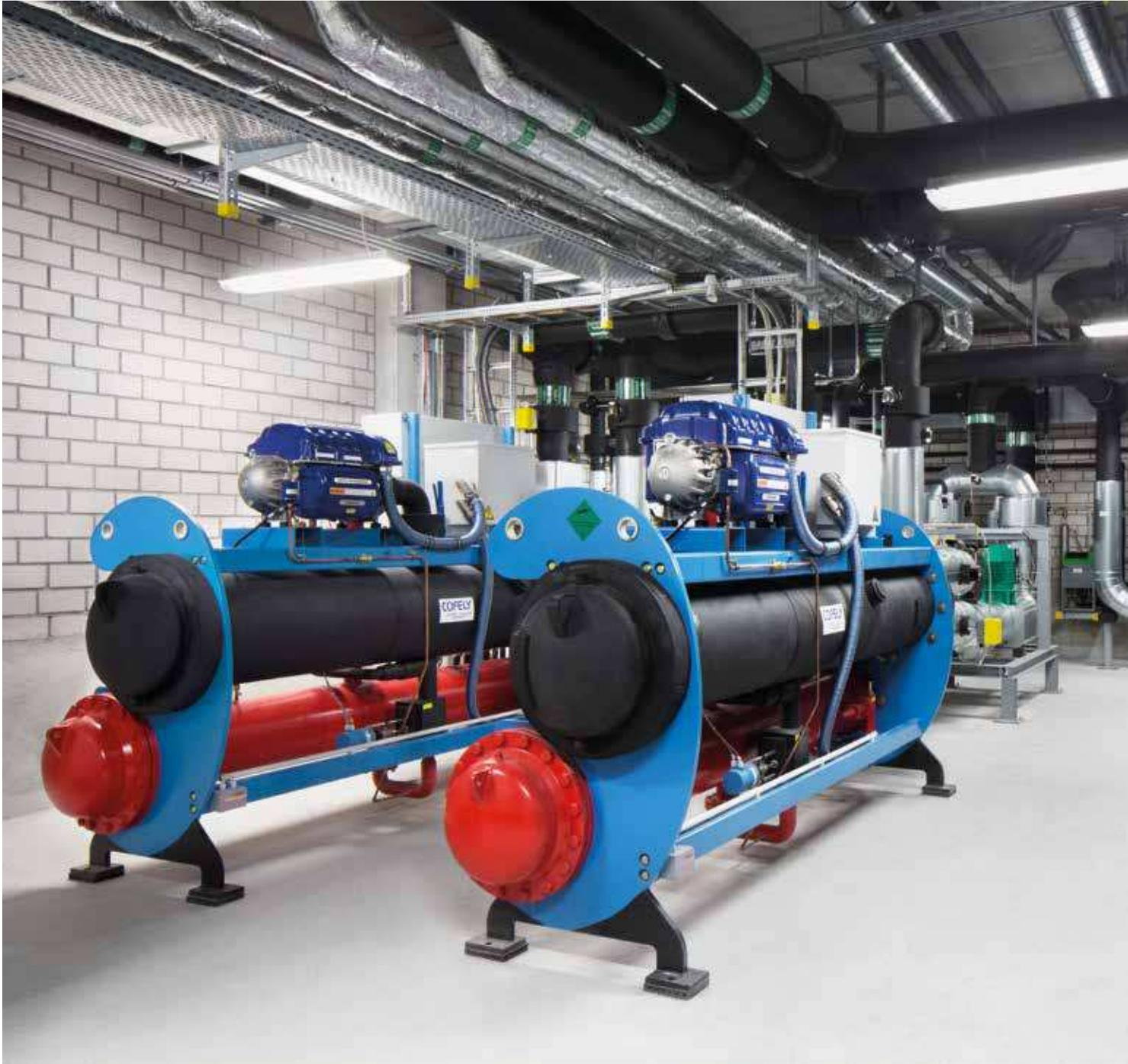
Die Kältezentrale im Untergeschoss beherbergt zwei Kältemaschinen mit einer Leistung von jeweils 390 kW.
