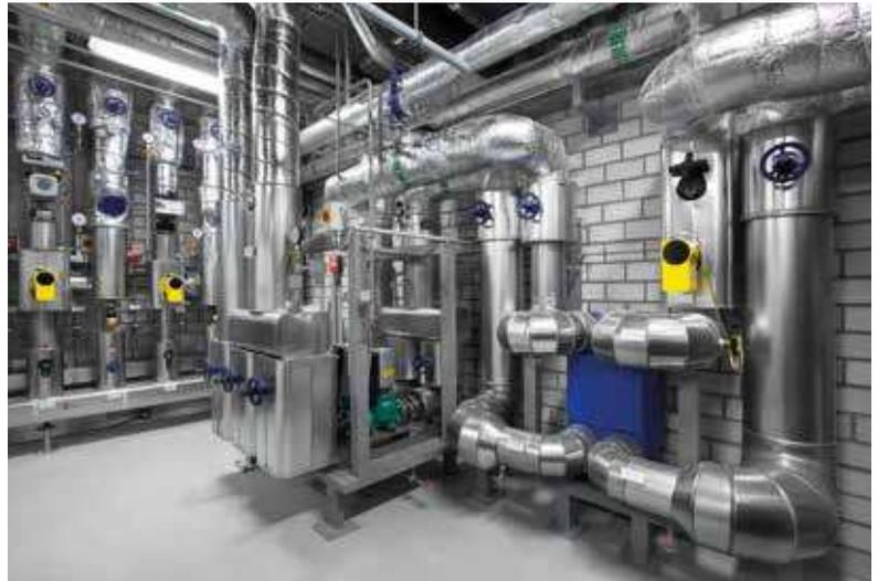
Wärmeverteilung mit Wärmetauscherstation zur Systemtrennung.
