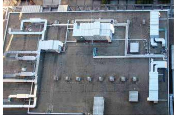
Die wetterfeste Lüftungszentrale wurde auf dem Dach des 2.OG montiert.
